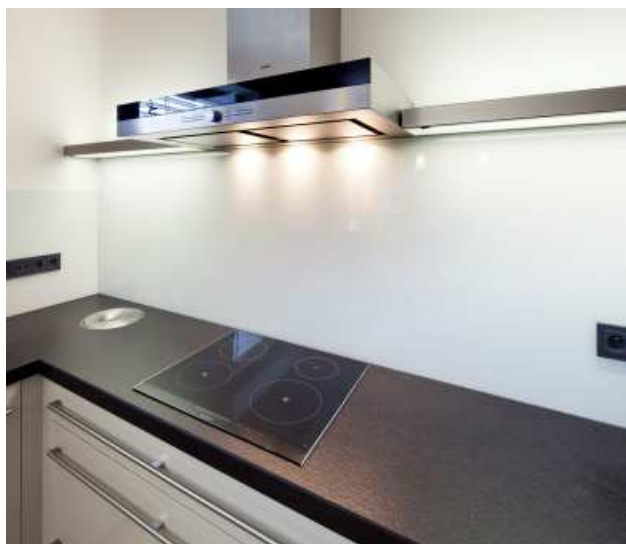
Obklad kuchyňské linky, sklo: Lepené bílé, ESG - 4.4.4
