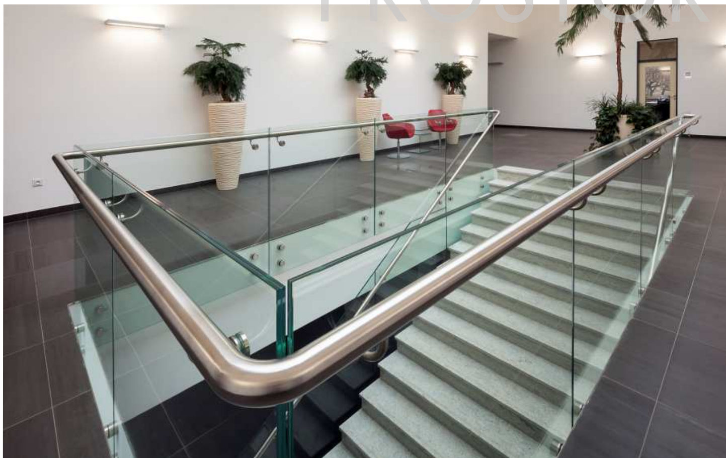
Skleněné zábradlí s madlem, sklo: Lepené čiré, ESG - 8.8.4
