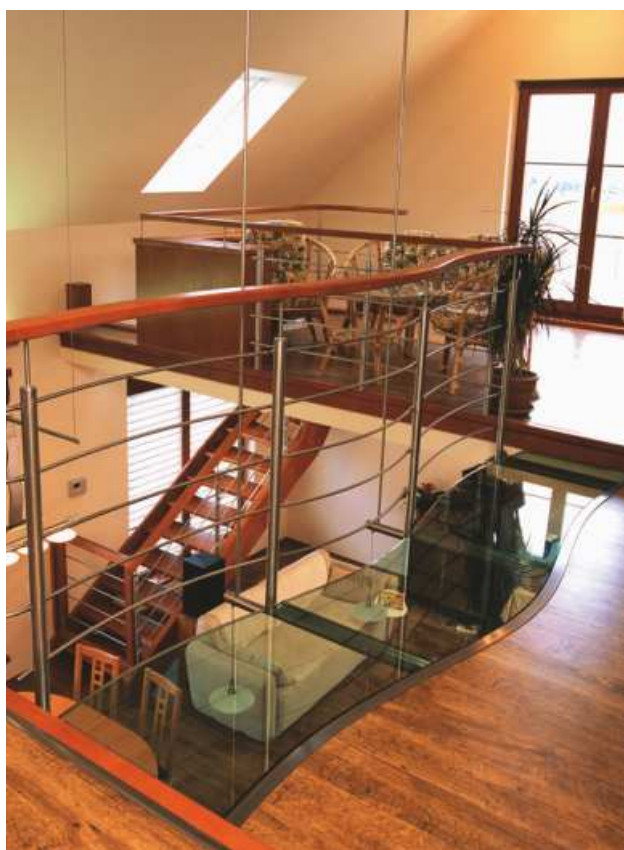
Pochozí deska, sklo: Lepené čiré 10.2.10.2.10, pískovaný dekor - atyp opláštění výtahové šachty, sklo: Lepené čiré, ESG - 8.8.4
