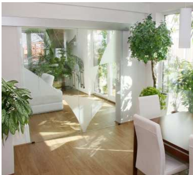
Sklo: Float čistý, gravírovaný a pískovaný dekor S GPM29 - atyp, kování: RS 120 + madlo MD 01
