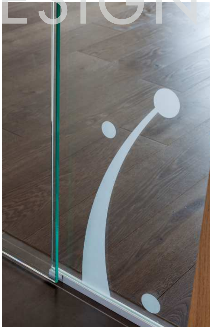
Detail fixní sklo + posuvné dveřní křídlo
