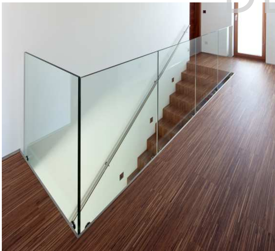
Skleněné zábradlí, sklo: Lepené čiré, ESG - 8.8.4
