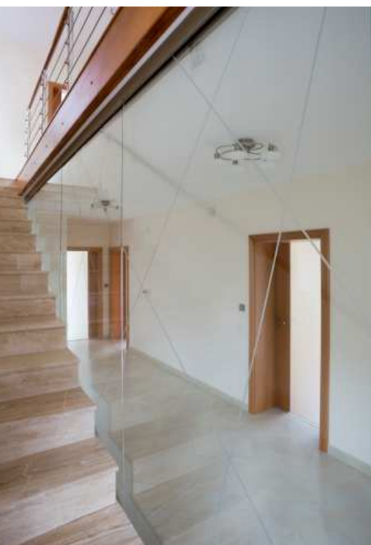
Jednokřídlé posuvné dveře na fixní skla - sloužící jako zábradlí, pískovaný dekor - atyp, sklo: Float čirý + Lepené čiré, kování: Agile 150 + madlo MD 02
