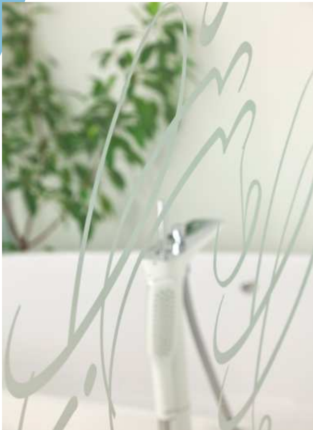
DETAIL PÍSKOVÁNÍ - POZITIV, SKLO: FLOAT ČIRÝ
