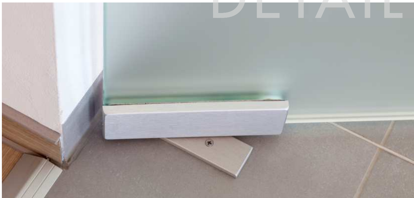
Detail spodního pantu PT Universal a čepu do podlahy
