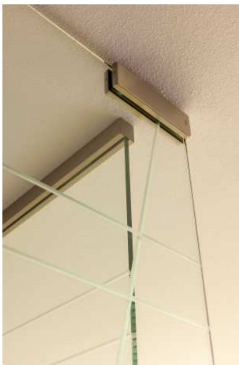
Detail horního pantu Universal PT
