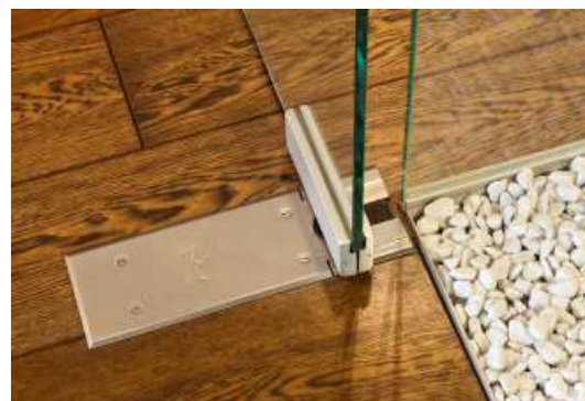
Detail podlahového zavírače
