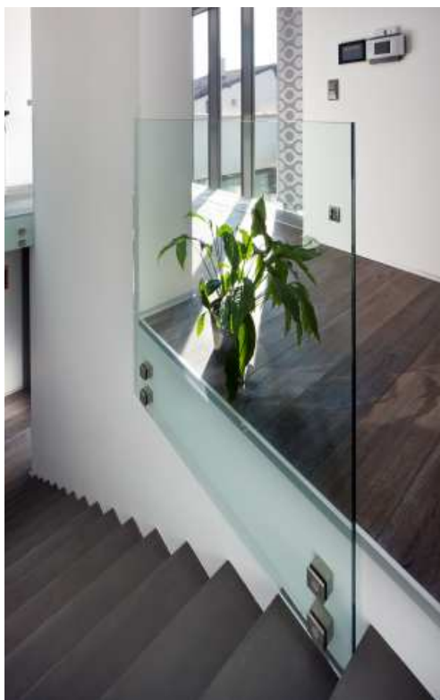
Skleněné zábradlí, sklo: Lepené čiré, ESG - 8.8.4, kování: hranaté terče
