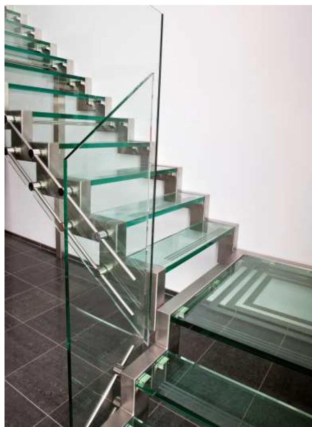
Schodiště se skleněnými nášlapy + pískování, sklo: Lepené čiré 10.2.10.2.10 + nerezová konstrukce zábradlí - sklo: Lepené čiré, ESG 8.8.4
