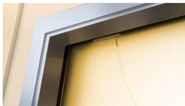
Detail horního okraje skla s úchytem
