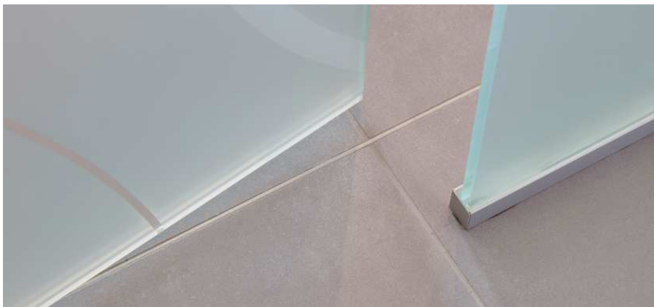
Detail spodního U profilu s boční krytkou
