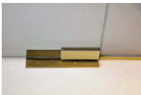
detail spodního pantu
