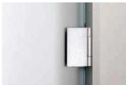
detail pantu z pohledové strany
