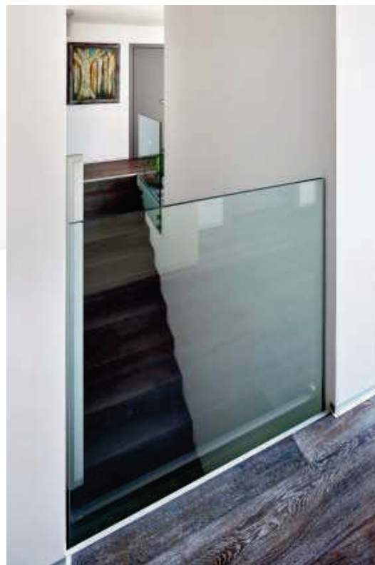
celoskleněné samonosné zábradlí, sklo: lepené čiré, ESG - 8.8.4
