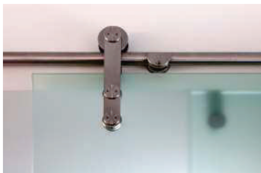
detail vozíku a kotvení kolejniče
