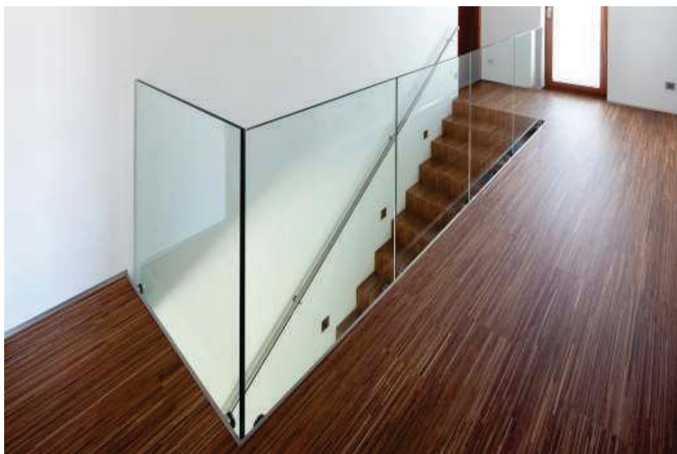
pohled na celoskleněné zábradlí z galerie, zábradlí - sklo: lepené čiré, ESG - 8.8.4
