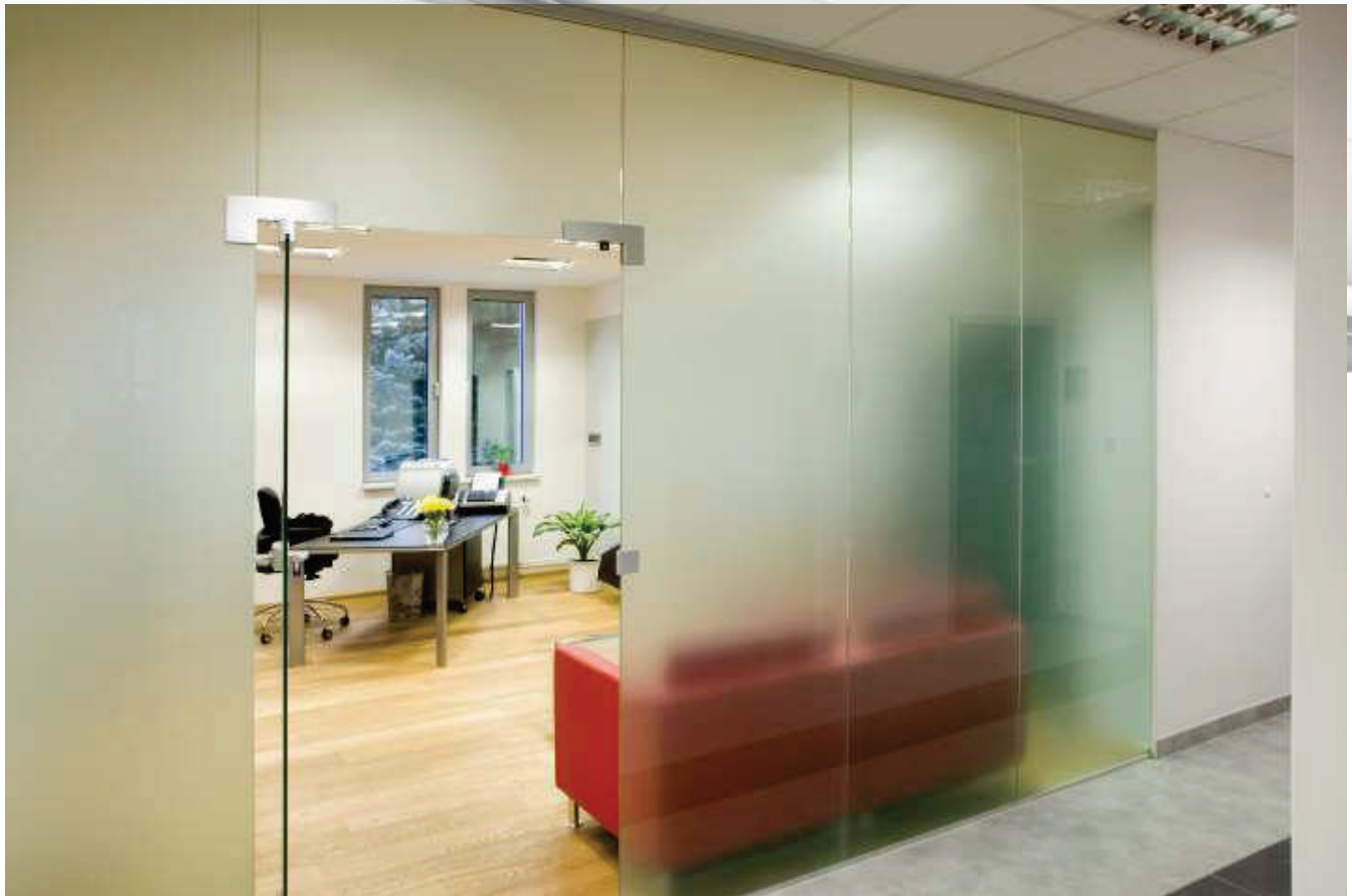
1-křídle otočné dveře 970/1970 mm s 4x BS a NS, stavební otvor: 4250/2620 mm, sklo: Satinát bílý 10 mm, kování: Arcos 03/114 + Arcos Universal PT + protikus + čep do podlahy
