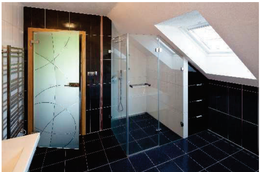
sprchový kout: 1-křídle otočné dveře s BS + BS 90°, rozměr 900/1000/1900 mm, sklo: Float čirý 8 mm s povrchovou úpravou proti usazování vodního kamene a zasychání vodních kapek, kování: Dorma BH 200 + madlo Quadrat 300
