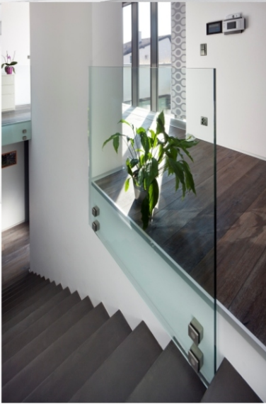
celoskleněné samonosné zábradlí, sklo: lepené čiré, ESG - 8.8.4, kování: hranaté terče
