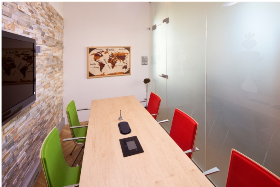
1-křídle otočné dveře s 4x BS a 1x NS, stavební otvor: 4100/2900mm, sklo: Satinátó bílé 10mm, vzor: pískování - atyp, kování: klikla Arcos 03/114 + panty Arcos Universal PT + protikus + čep do podlahy
