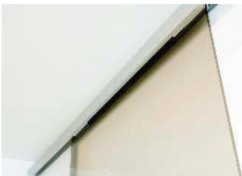
detail - spodní pohled do kolejnice
