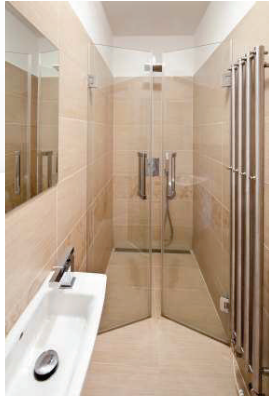
sprchový kout: 2-křídle kyvné dveře, rozměr 900/2100 mm, sklo: Float čirý 8 mm s povrchovou úpravou proti usazování vodního kamene a zasychání vodních kapek, kování: Dorma BF 134 + madlo Quadrat 300
