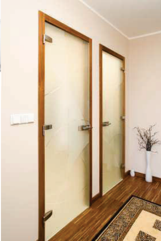
1-křídle otočné dveře 800/2200 mm do obložkové zárubně, sklo: Satináto bronz 8 mm, vzor: S GPM29, kování: Arcos 01/107
