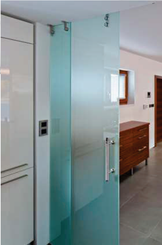
2-křídle posuvné dveře přes 2x BS, stavební otvor: 2670/2300 mm, sklo: Satínato bílé 10 mm, kování: Manet 4.1 + madlo MD 01
