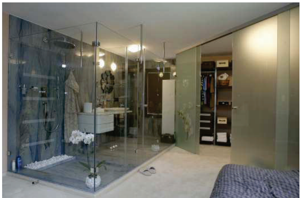
vlevo: atypická sprchová stěna se sprchovým koutem, sklo: Float čirý 8mm s povrchovou úpravou proti usazování vodního kamene a zasychání vodních kapek, kování: Dorma BH 200 vpravo: 2-křídle posuvné dveře na 2x BS, stavební otvor: 4500/2500mm, sklo: Satináto bílé 10 mm, kování: Agile 150 + čočka KN 03
