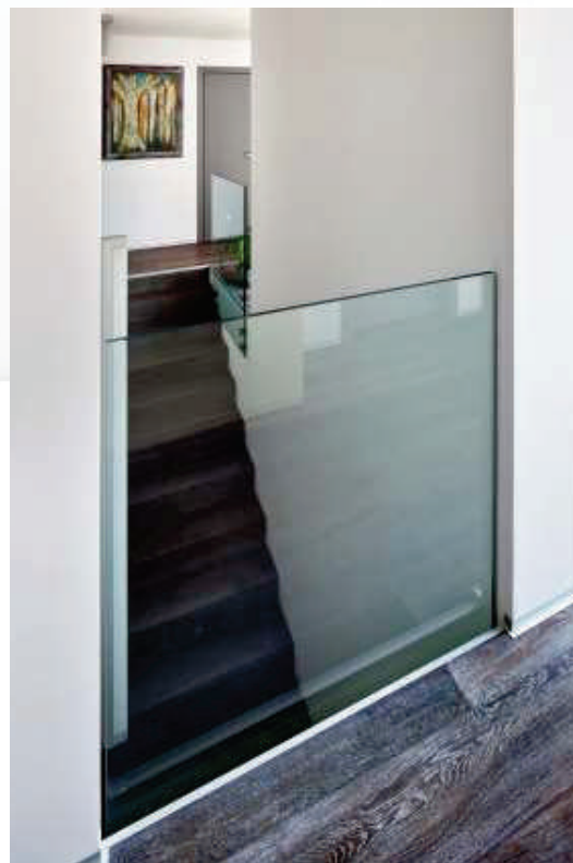
celoskleněné samonosné zábradlí, sklo: lepené čiré, ESG - 8.8.4
