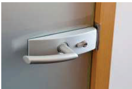
detail kliky s protiplechem do zárubně
