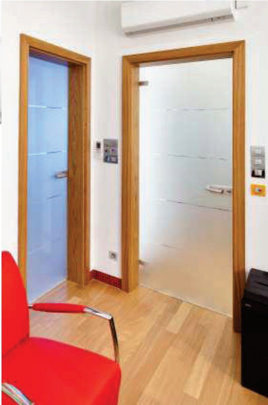
1-křídle otočné dveře 900/2200 mm do obložkové zárubně, sklo: Satináto bílé 8 mm, vzor: gravír - atyp, kování: Arcos 03/114
