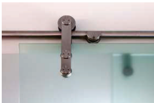
detail vozíku a kotvení kolejniče
