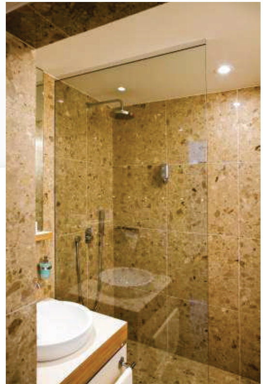
fixní sprchová zástěna, rozměr 1100/2400 mm, sklo: Float čirý 8 mm s povrchovou úpravou proti usazování vodního kamene a zasychání vodních kapek, kování: Dorma - horní sprchový profil
