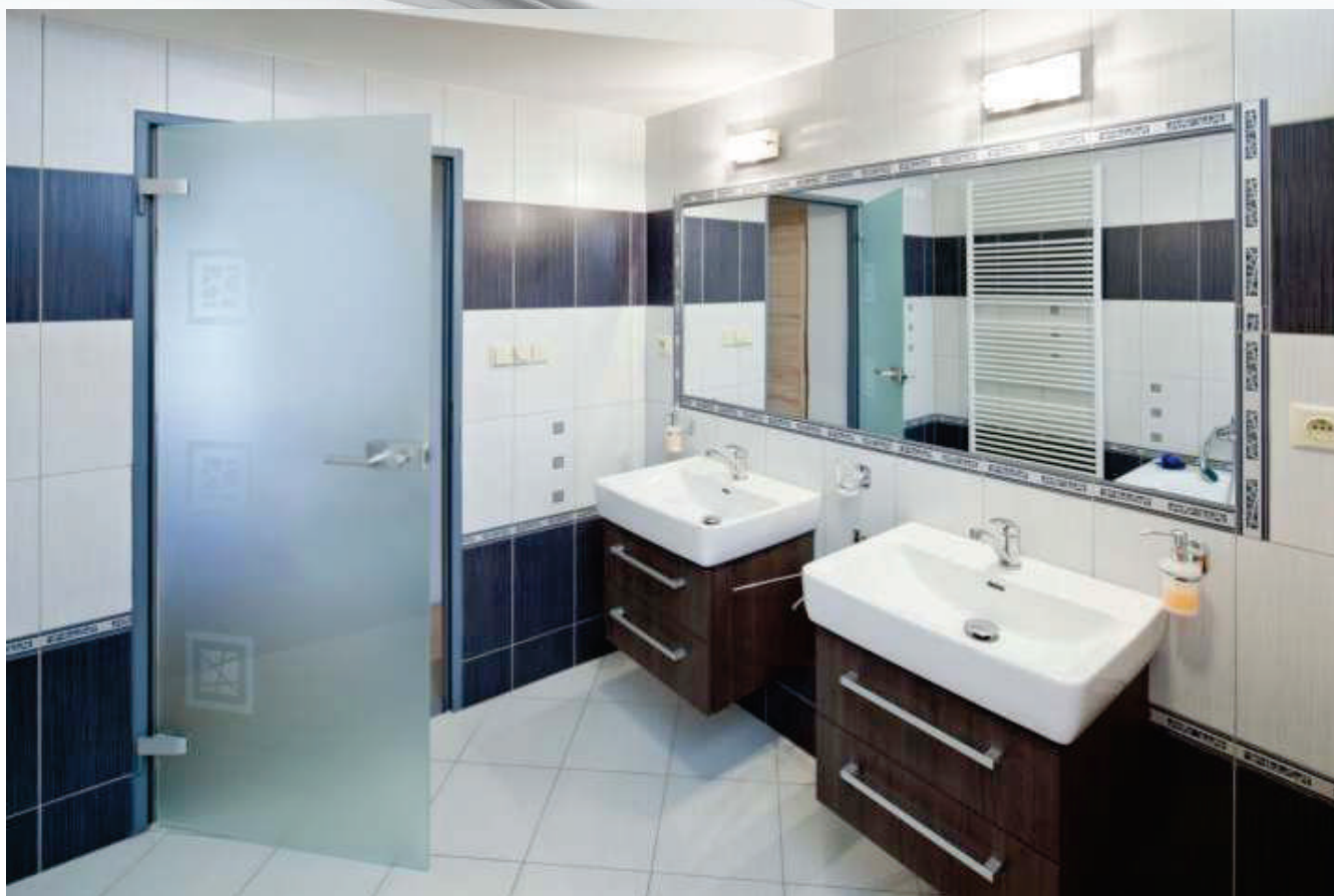
1-křídle otočné dveře 800/1970 mm do obložkové zárubně, sklo: Satináto bílé 8 mm, vzor: pískování - atyp, kování: Siena 03/101 + vložka s WC olivkou
